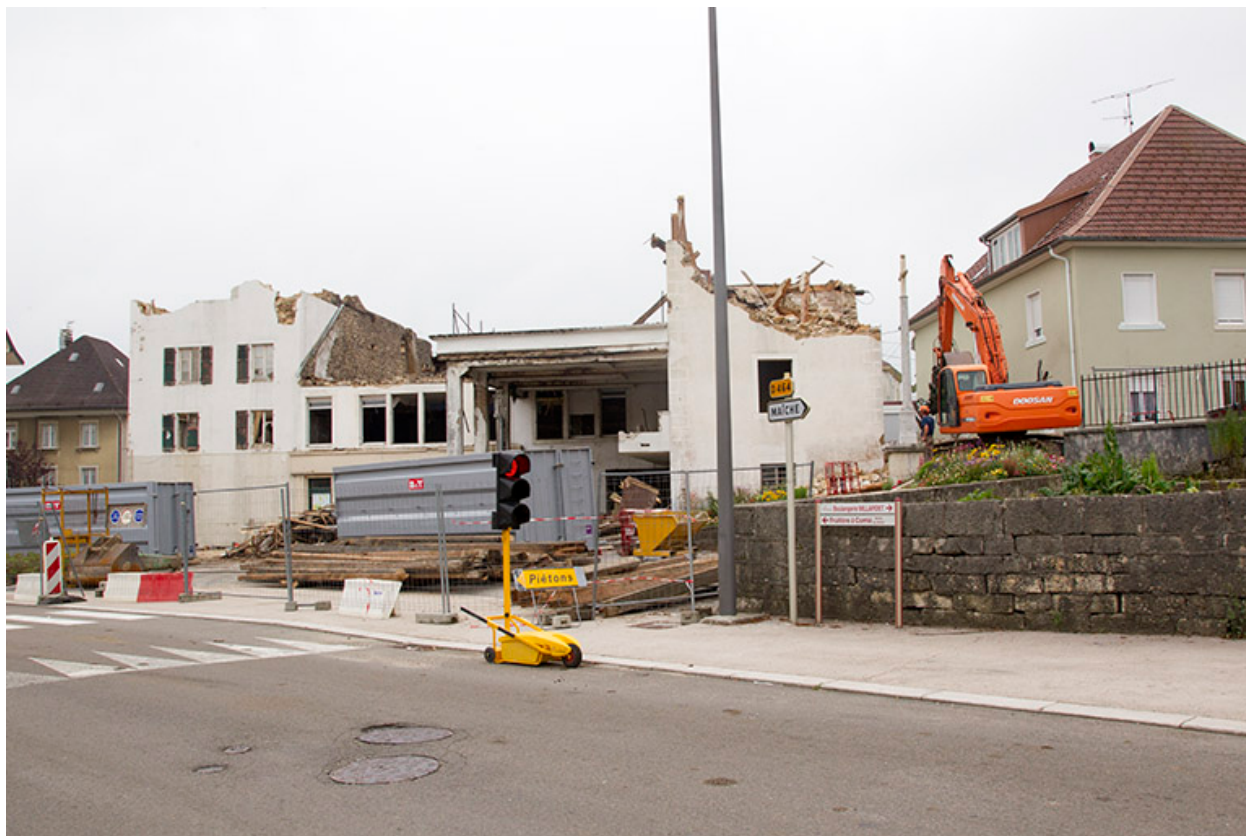
Destruction des bâtiments, 5 septembre 2012 : façades nord.
