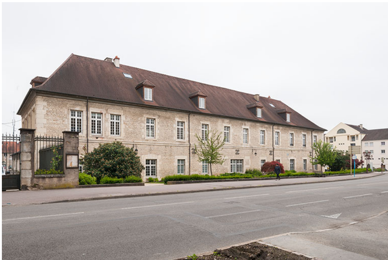
Atelier-externat : façade sur la rue des Arènes.
