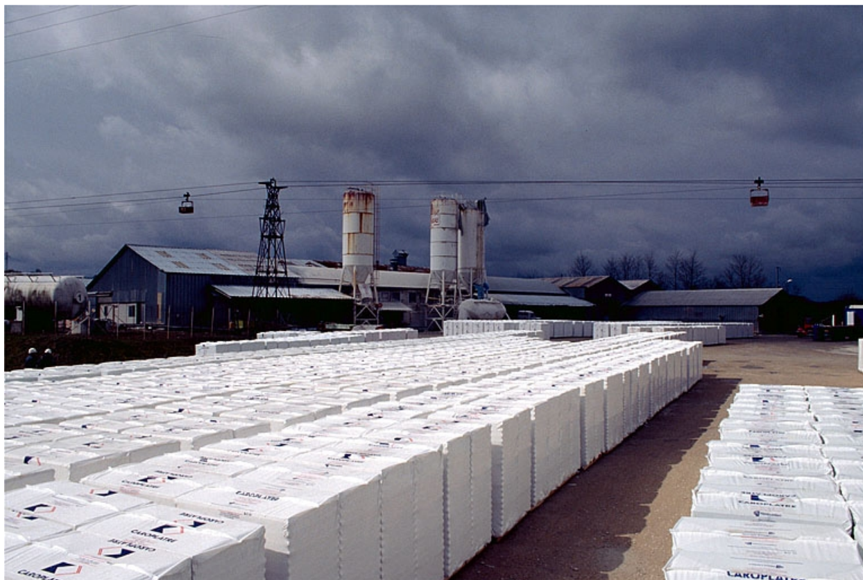
Plâtrières modernes de Grozon.
