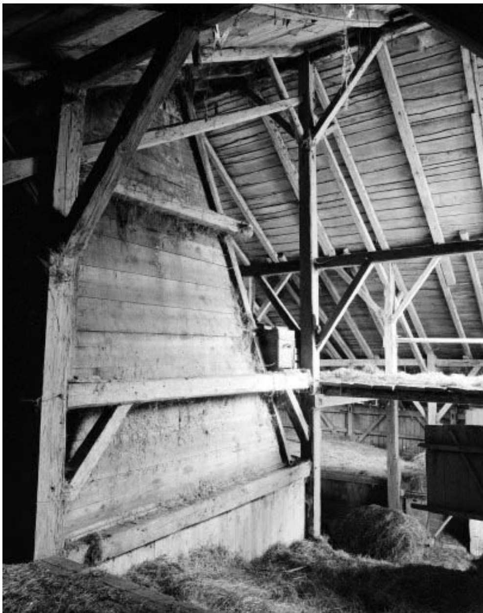
Charpente et tué.
