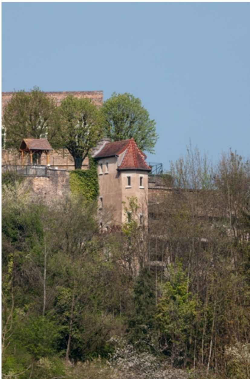
Bâtiment (H), tour d'escalier.
