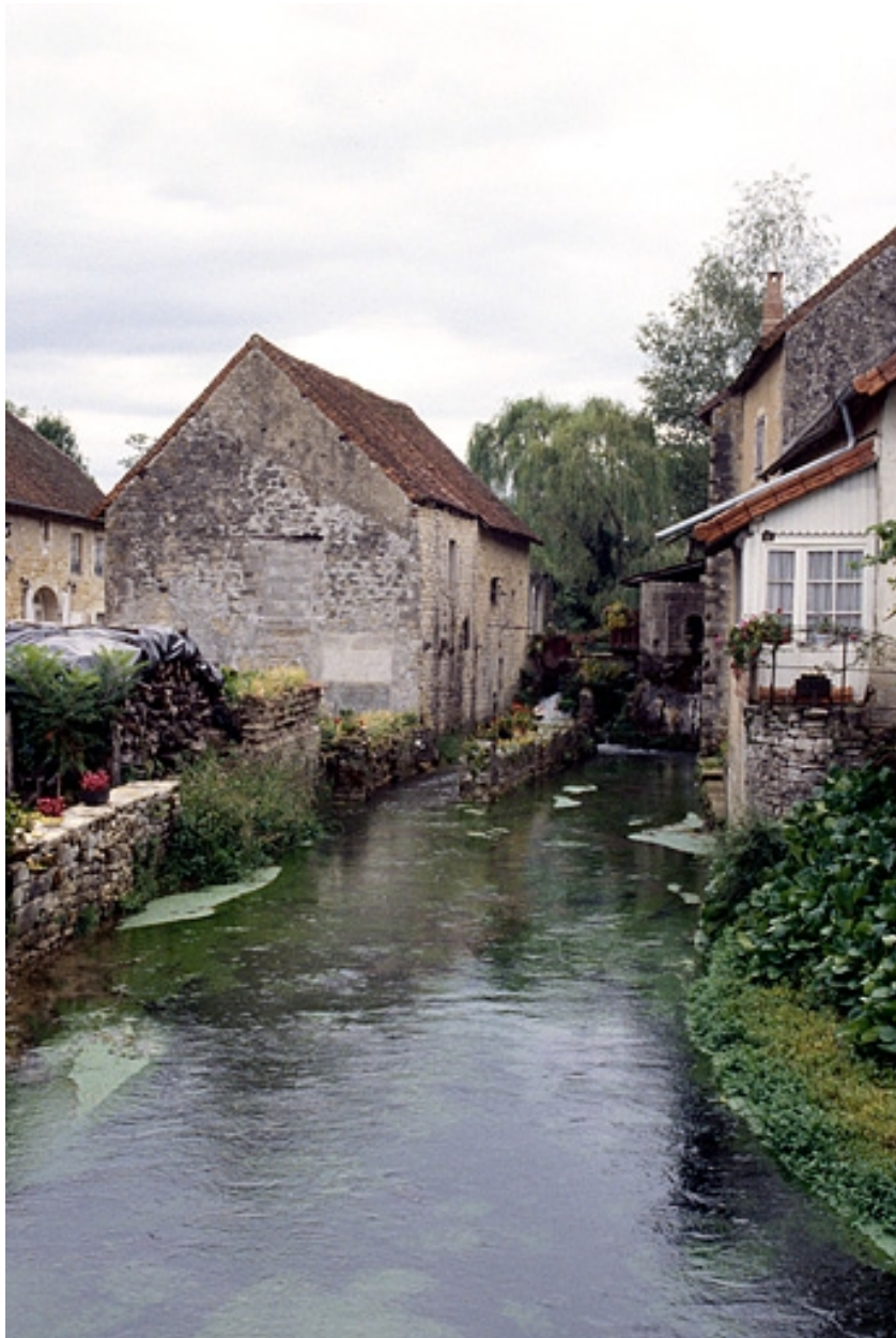
Ancienne huilerie et façade postérieure.
