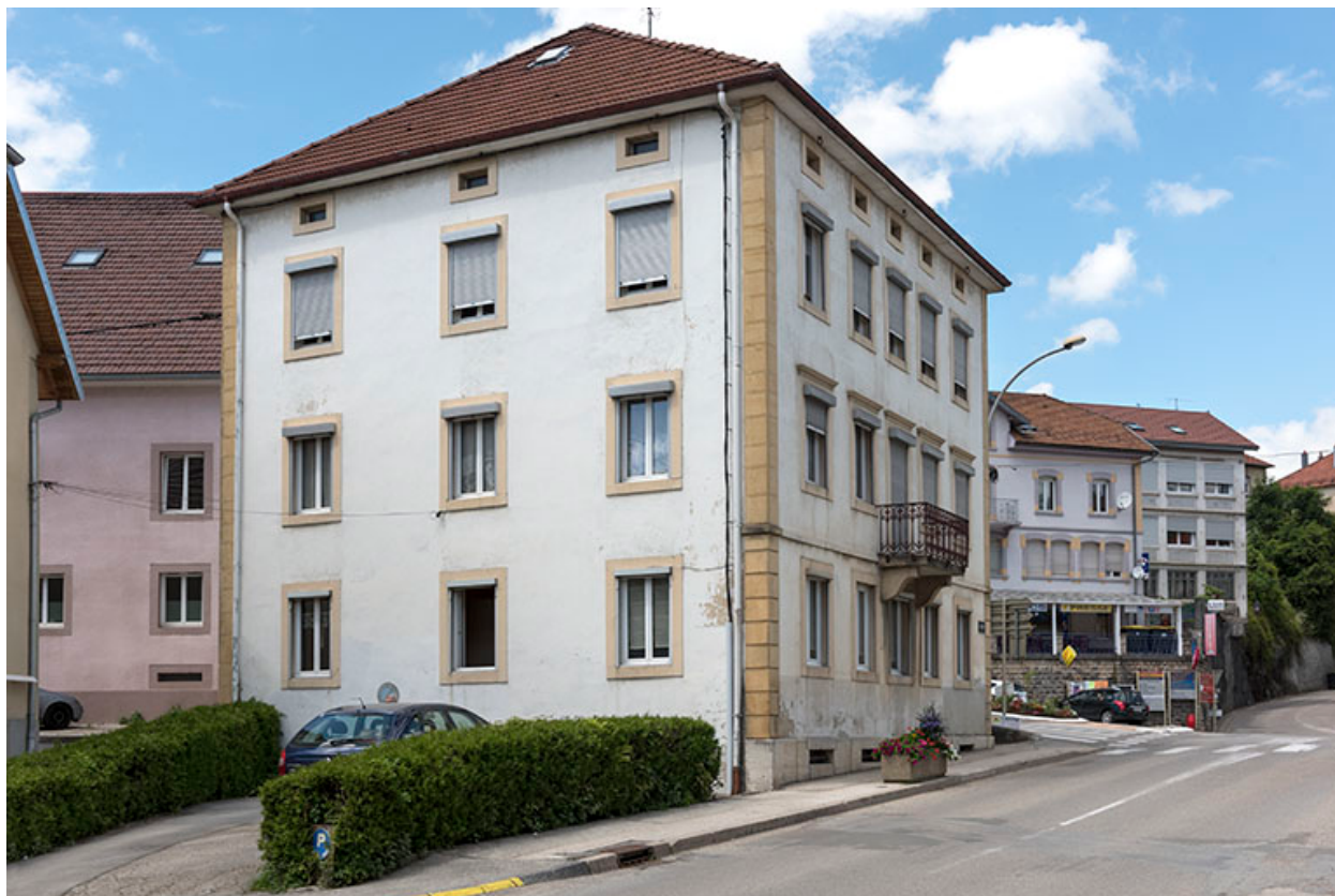
Façades antérieure et latérale gauche.
