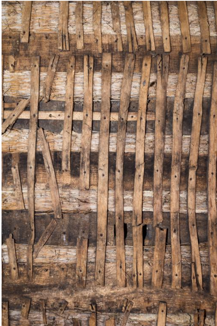
Détail d'un plancher dans la dépendance, constitué de pièces de bois (solives), de bottes de paille et couvert d'un lattis
