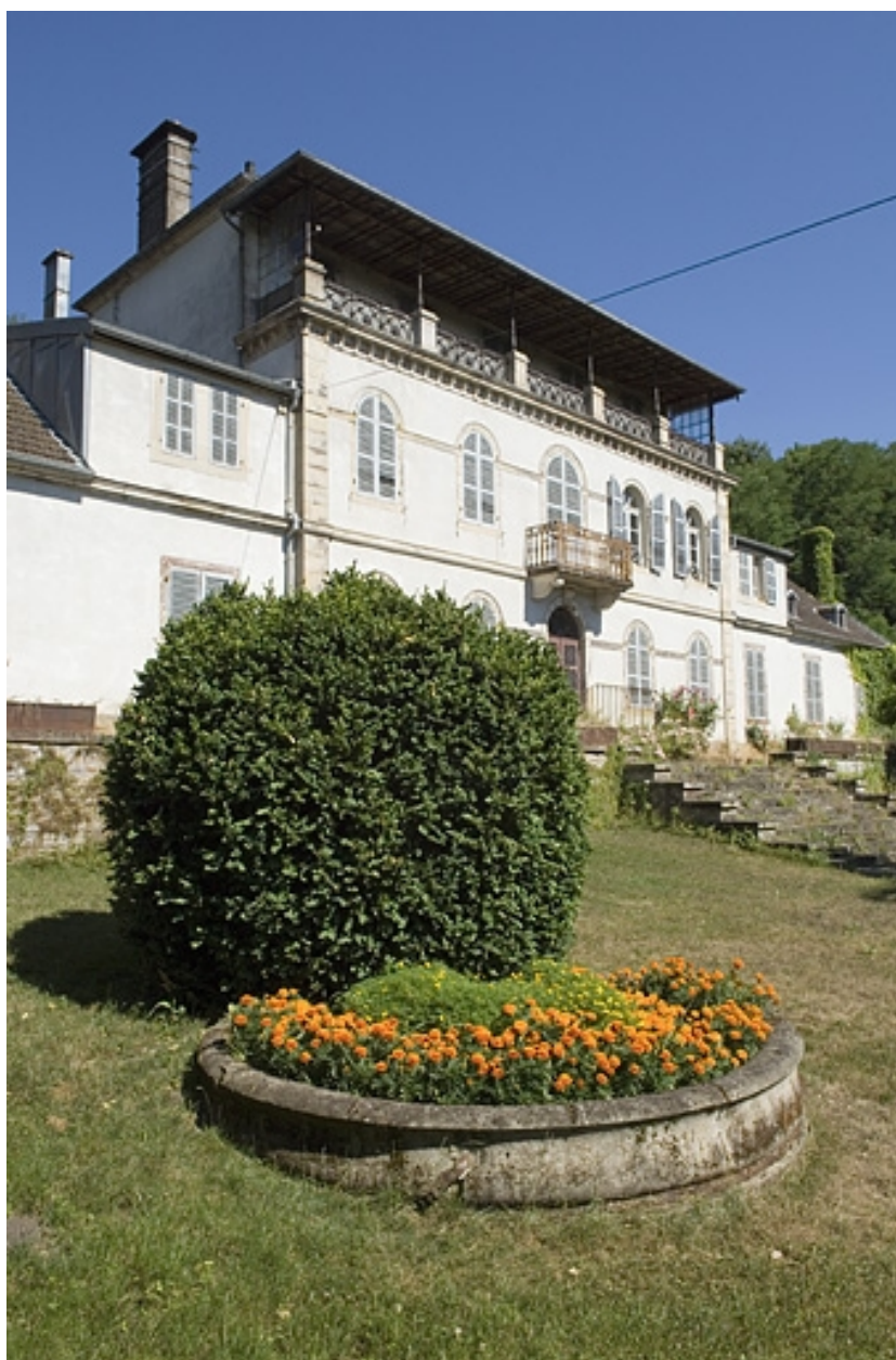
Logement patronal nord. Vue de trois quarts.
