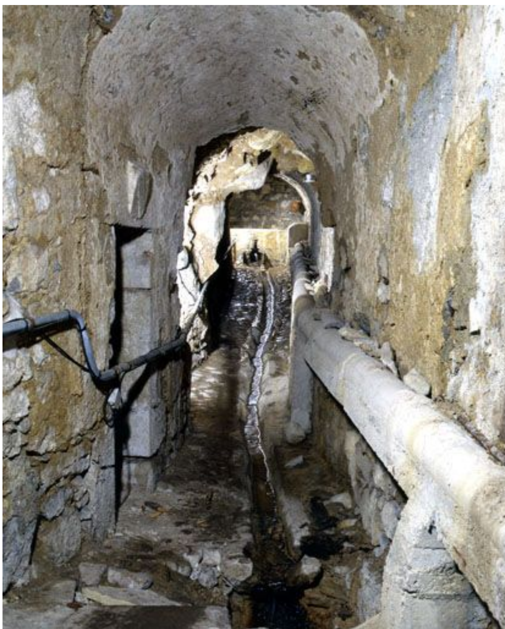
Conduit hydraulique des infirmeries vu depuis l'entrée.
