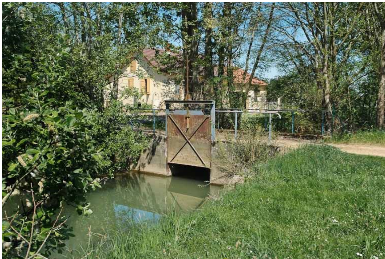
Vue d'ensemble : vanne.
