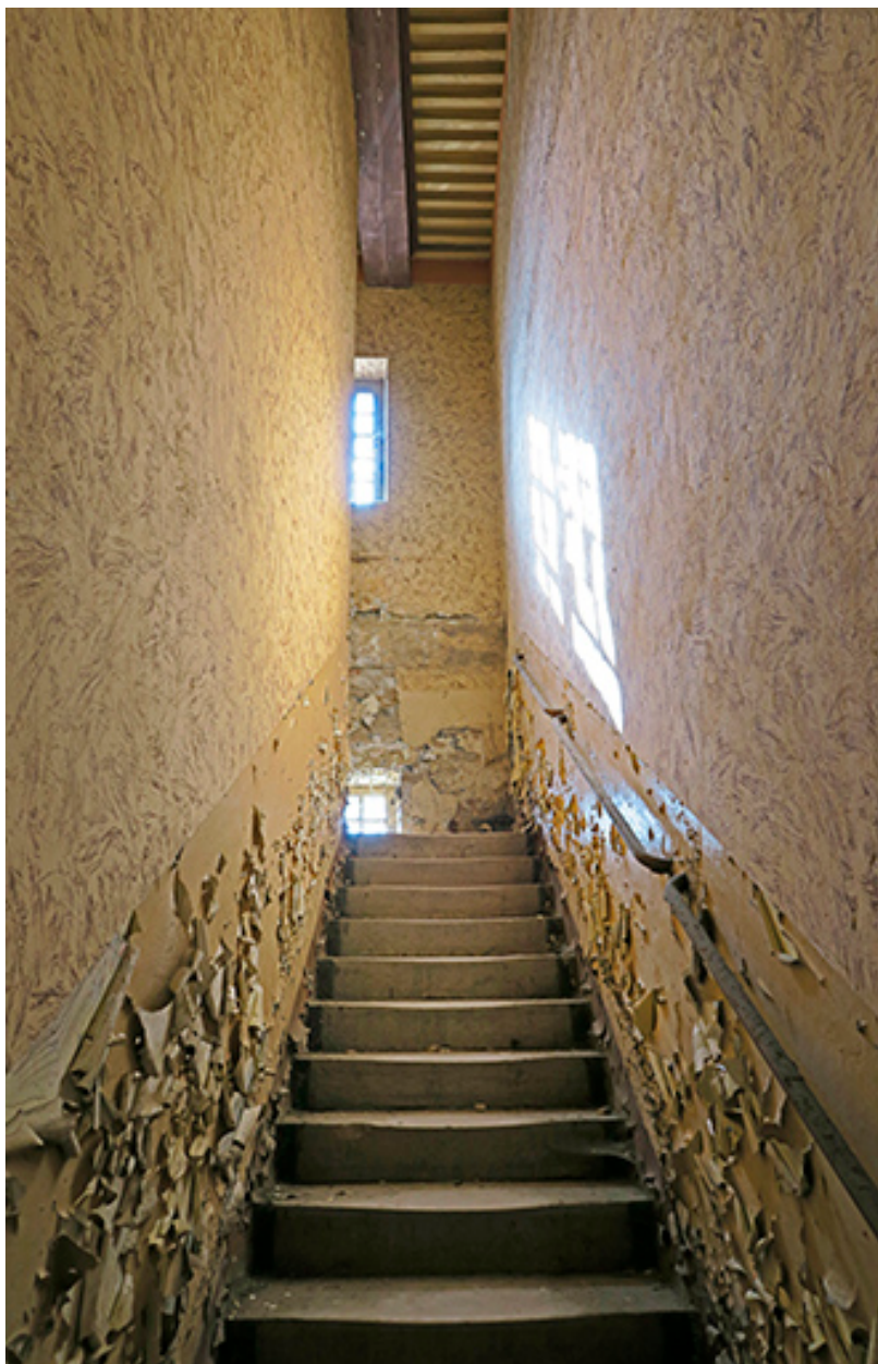
Première volée de l'escalier nord des prisonniers.
