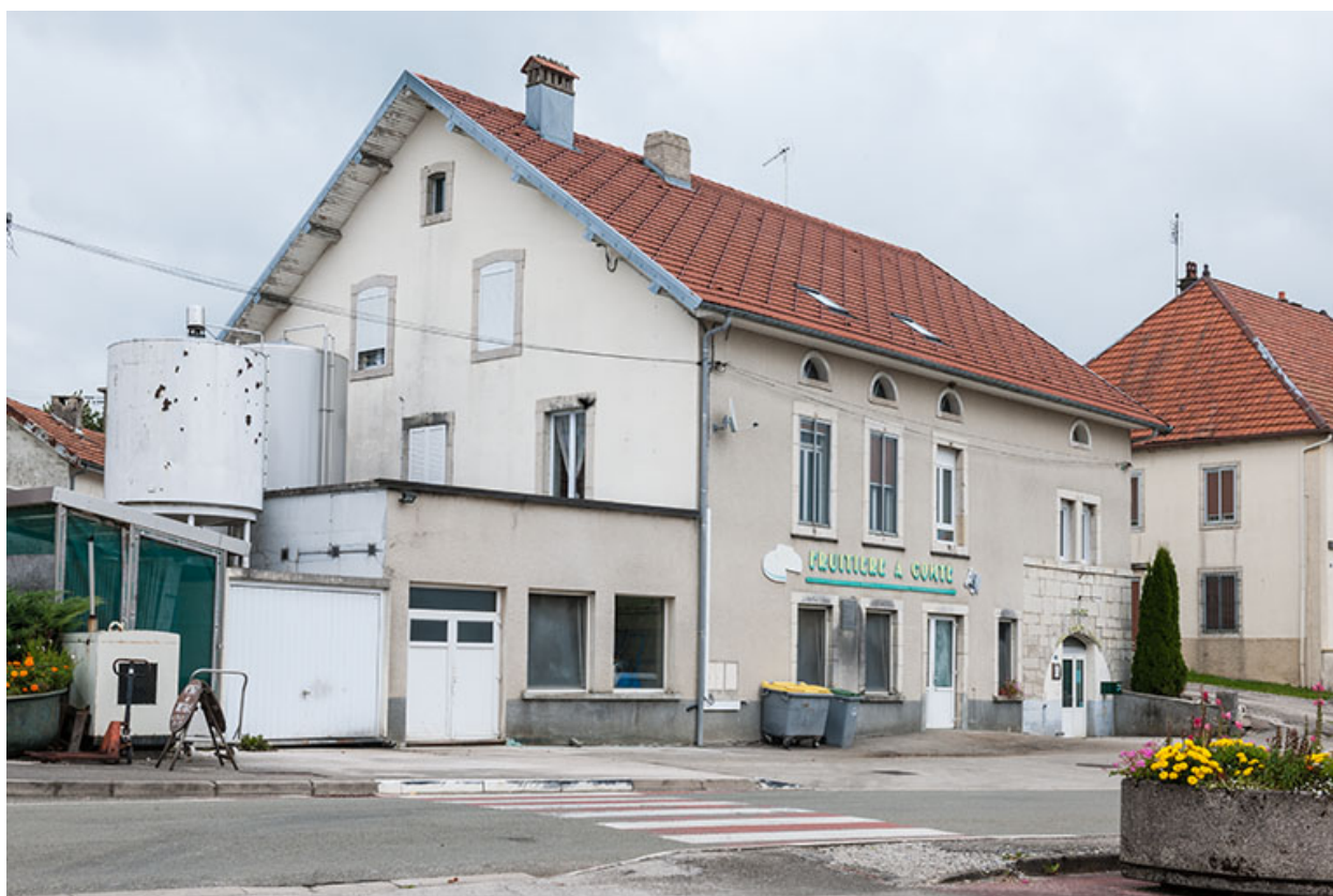
Vue depuis le sud-ouest.
