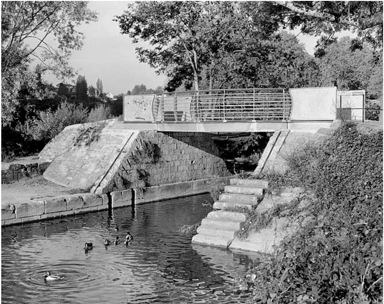
Passerelle de halage, depuis l'aval.
