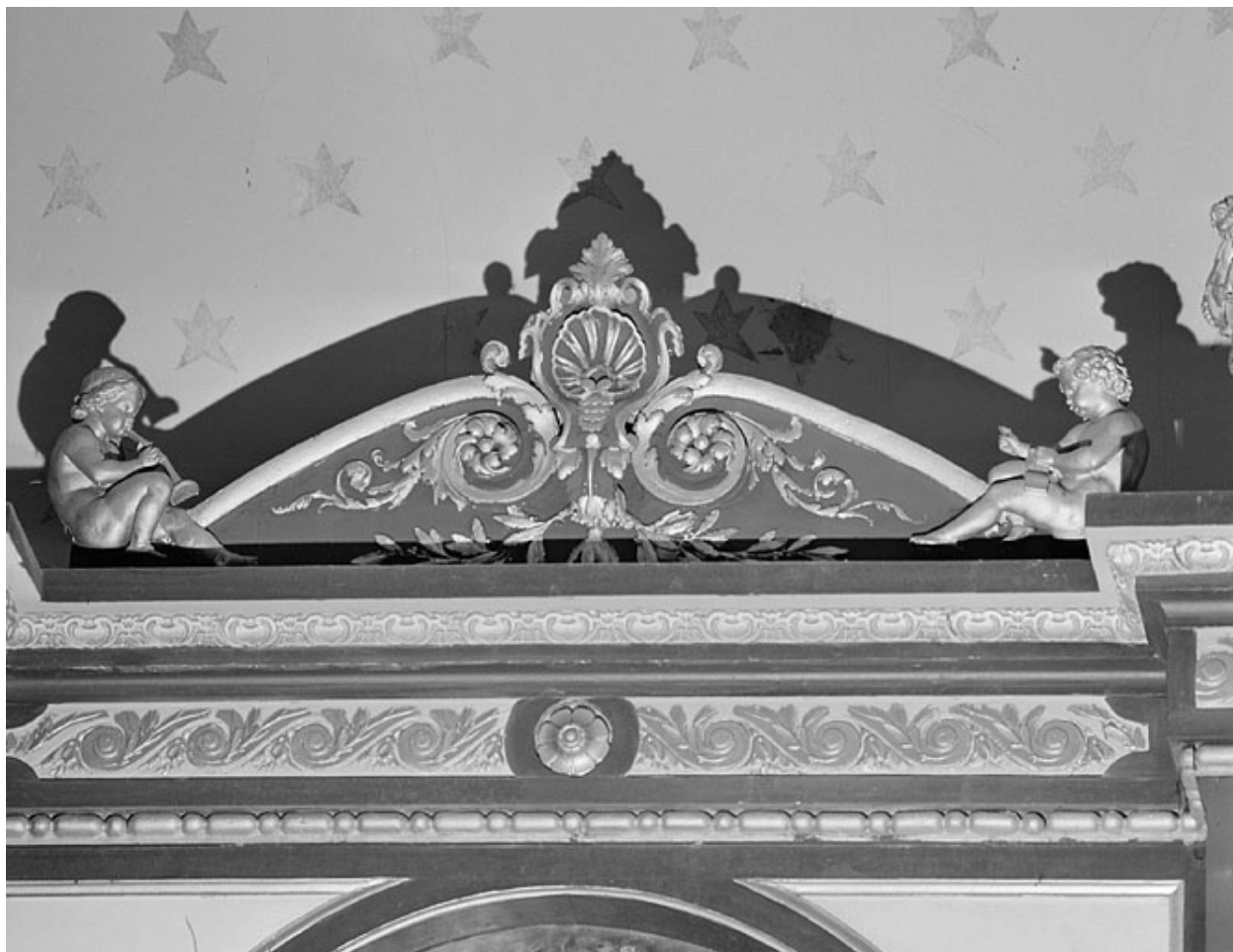
Détail du couronnement.
