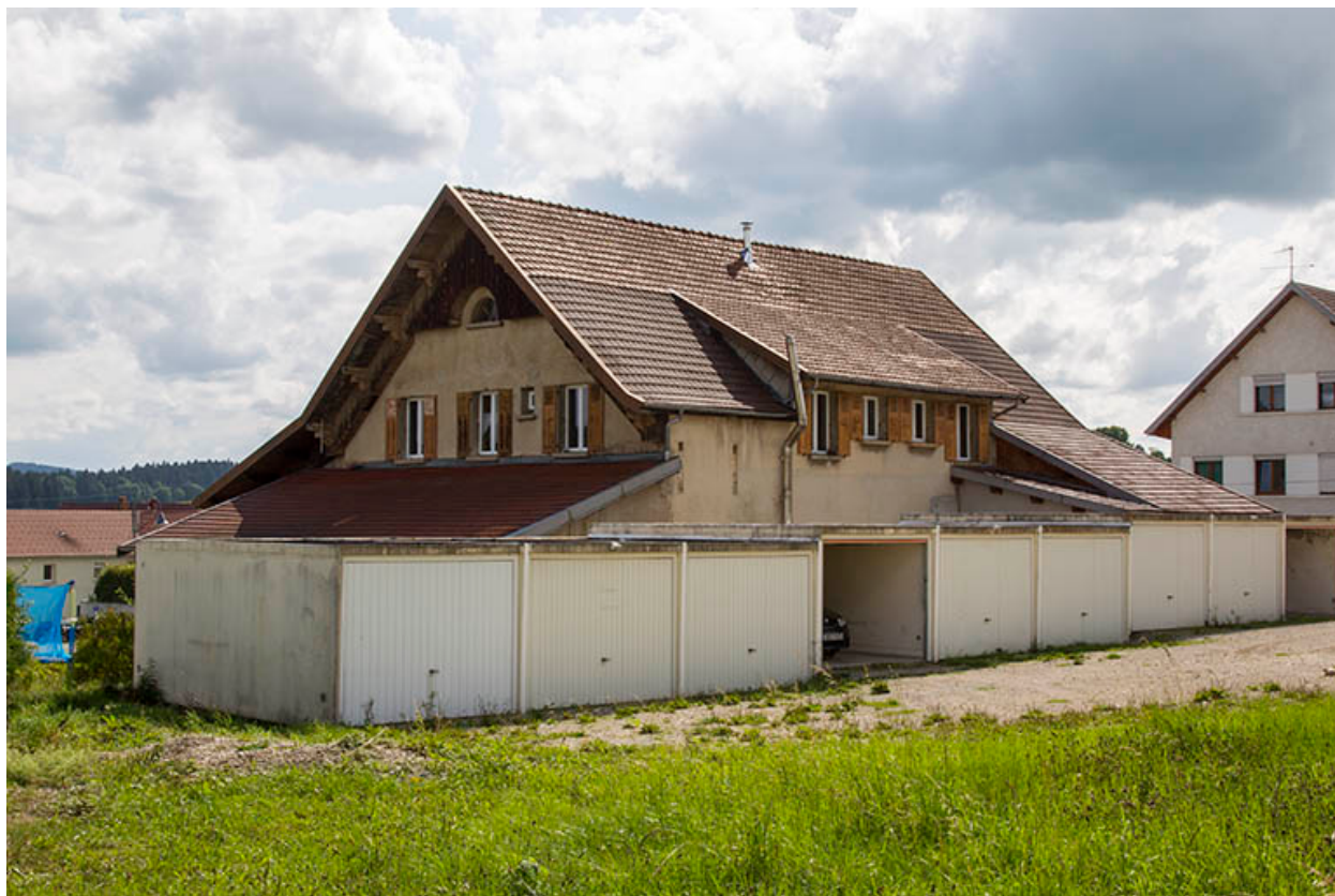
Façades postérieure et latérale gauche.
