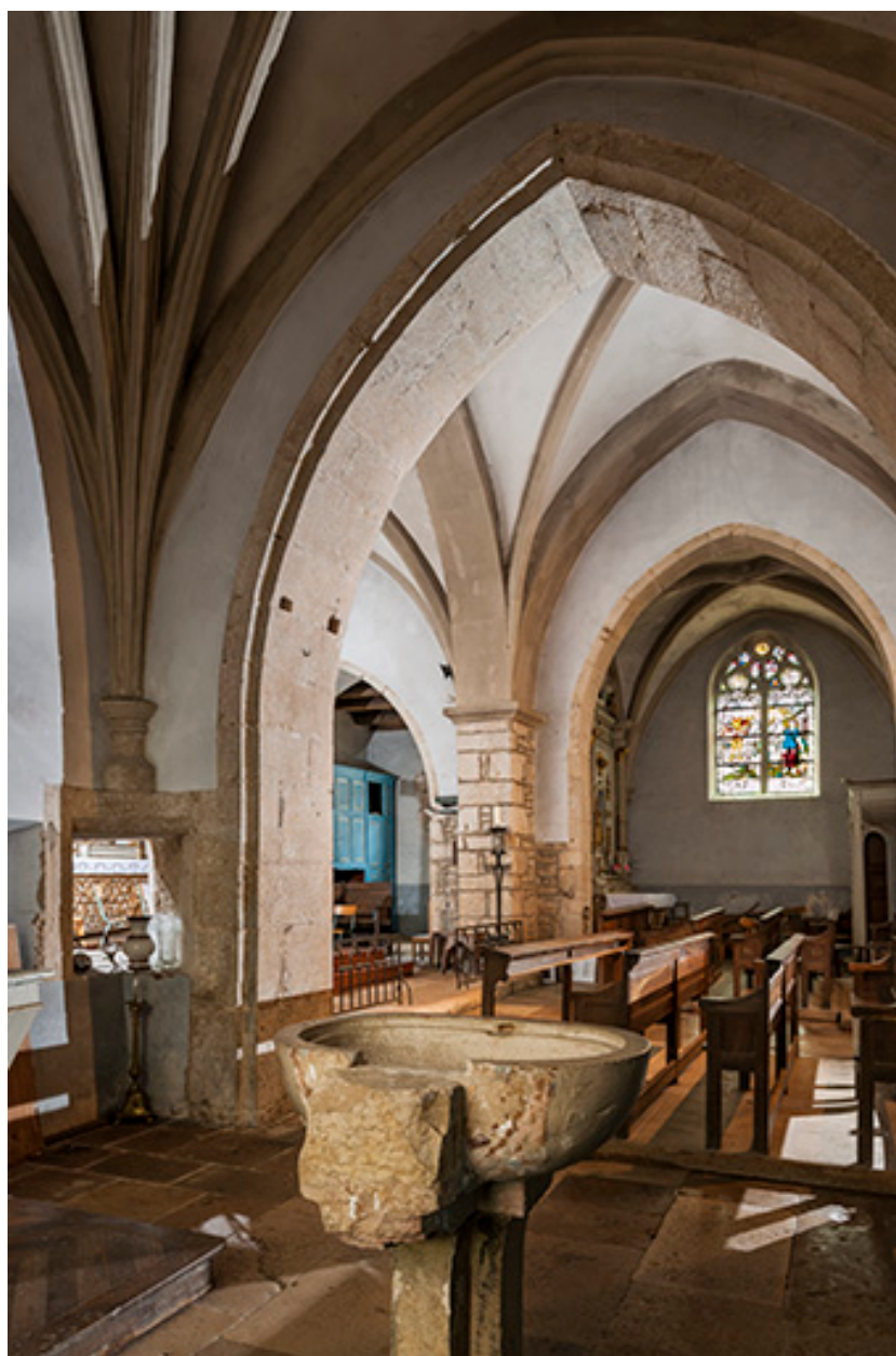
Vue depuis la chapelle latérale nord.
