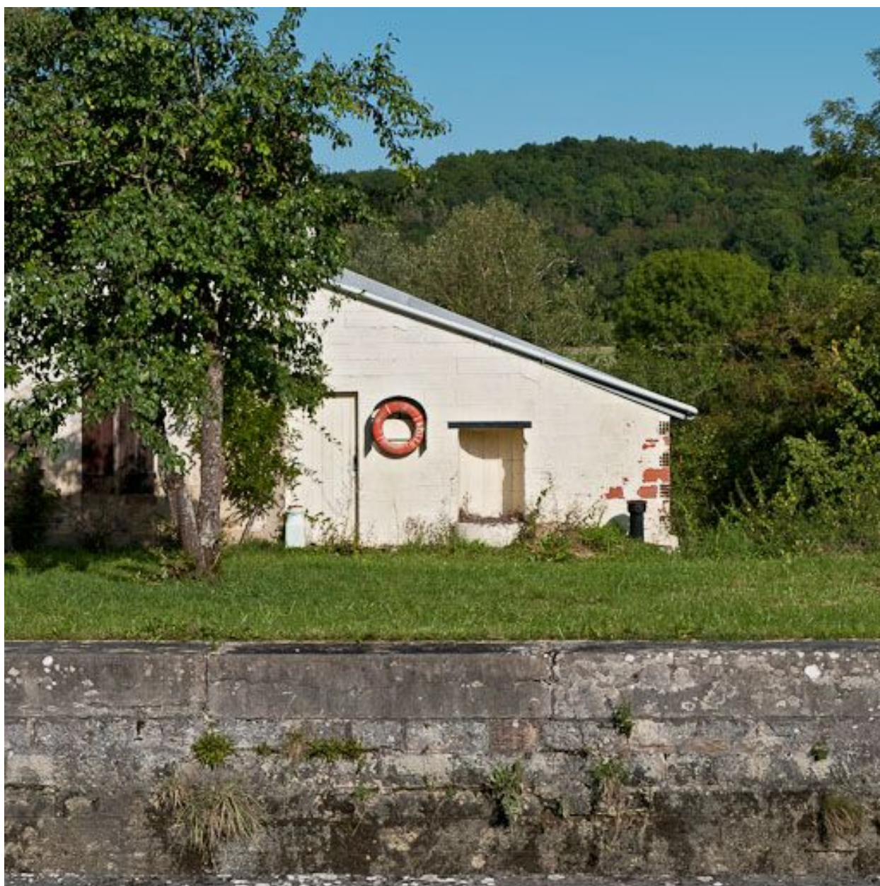
Vue de l'extension latérale.
