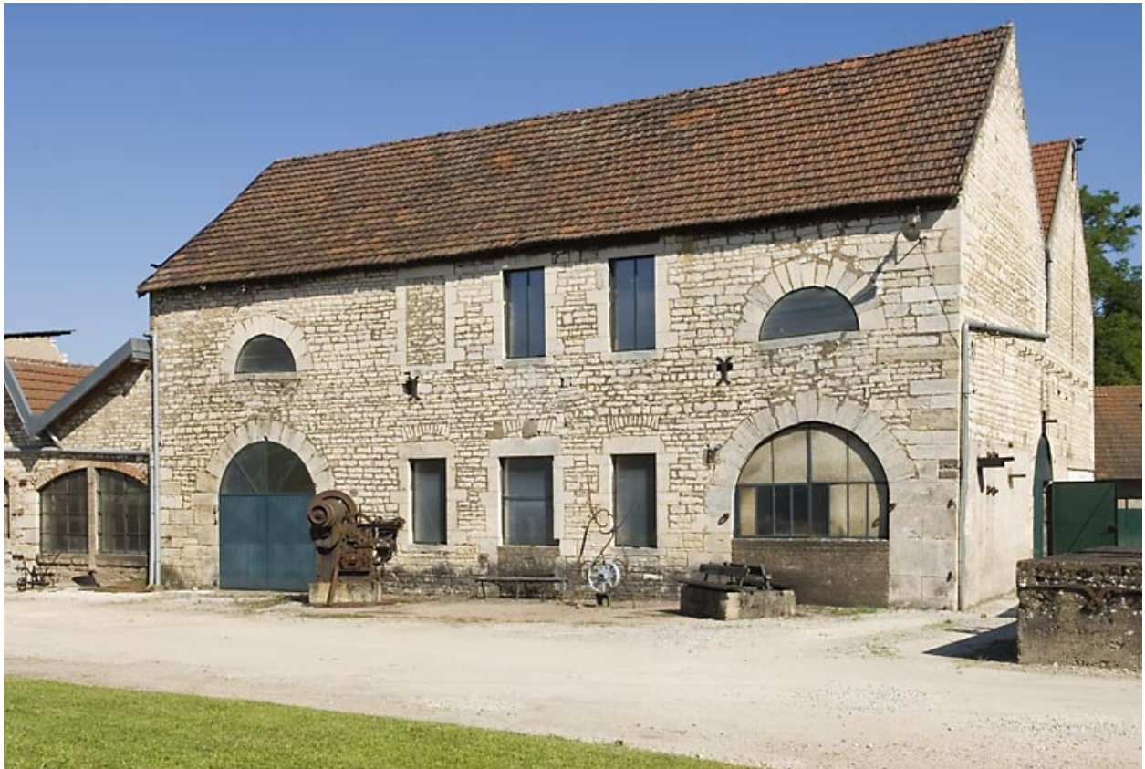
Bâtiment du haut fourneau est.
