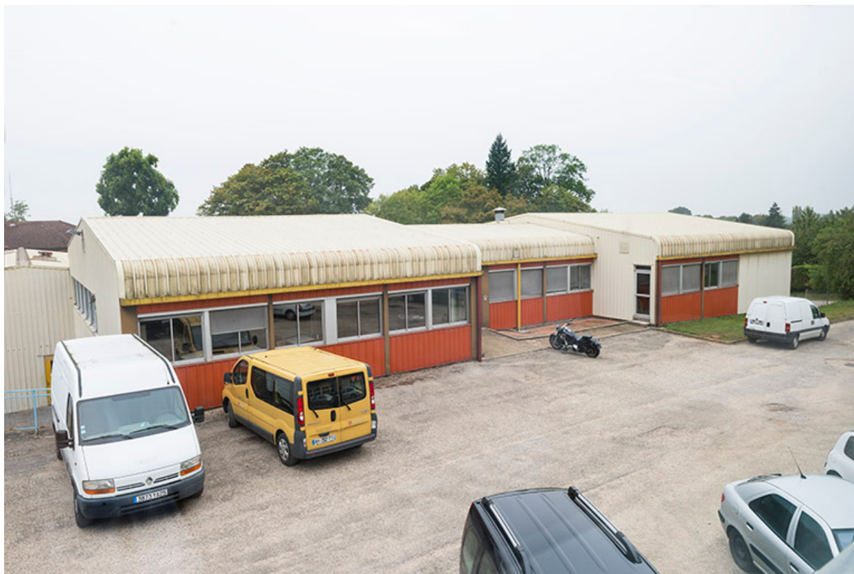
Vue des ateliers depuis l'externat
