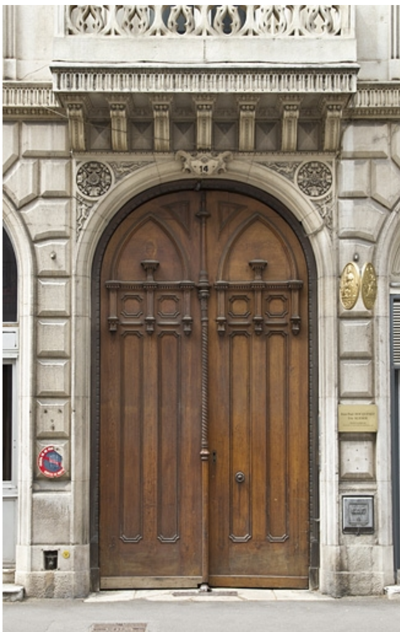
Vue des vantaux du portail d'entrée.
