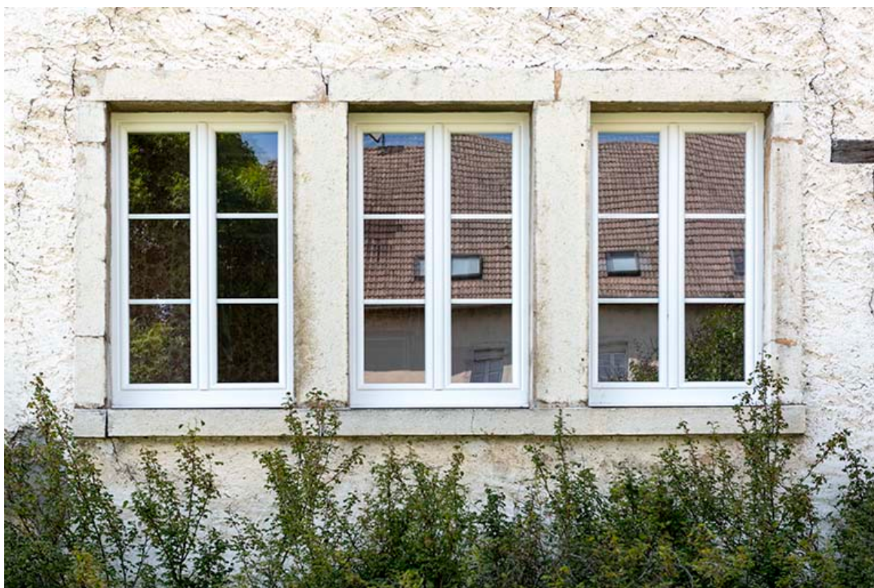
Façade latérale droite : fenêtres multiples.
