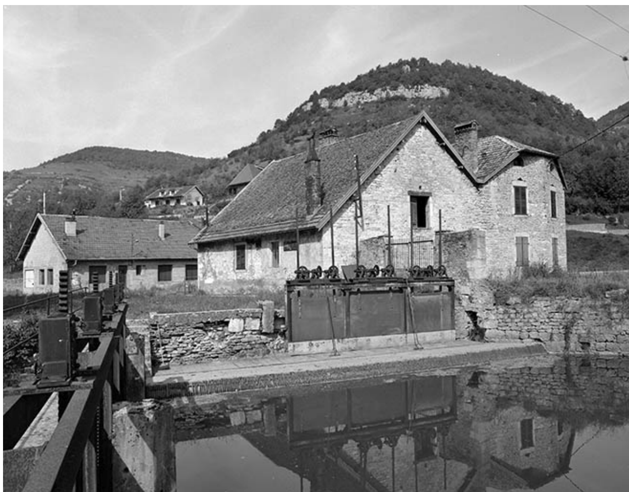
Vue d'ensemble depuis le barrage en 1980.
