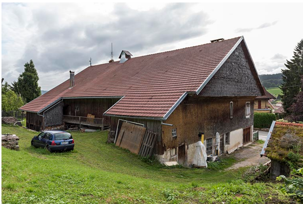
Façades postérieure et latérale gauche.
