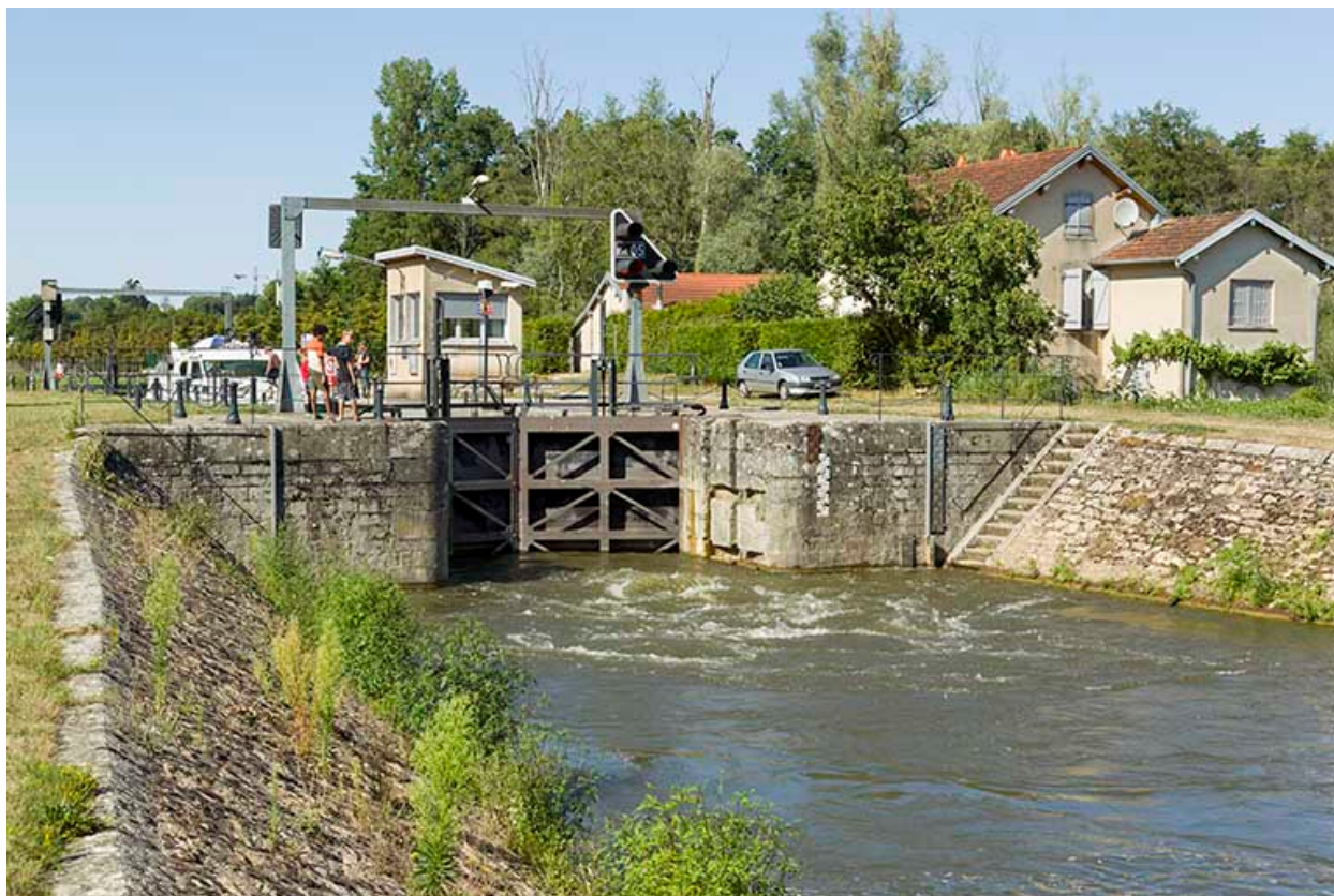
L'écluse depuis l'aval.
