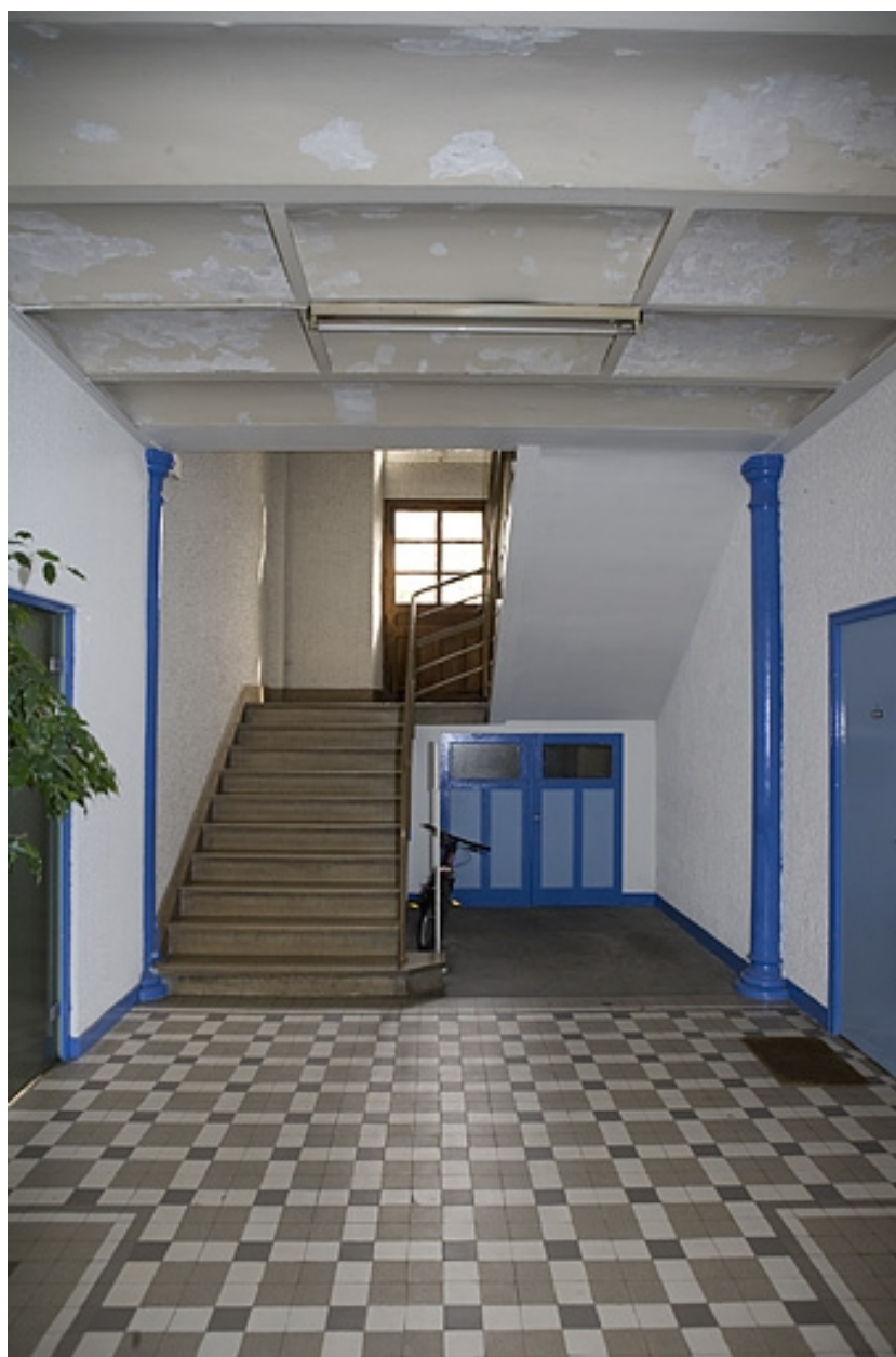
Intérieur de l'entrée : escalier, poteaux en fonte et voûtaings.
