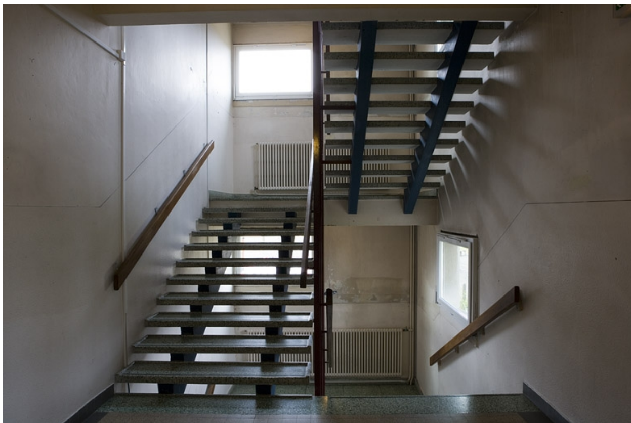
Bâtiment A. Intérieur: escalier.
