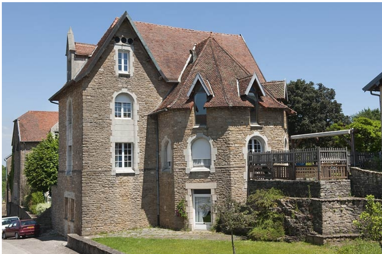
Bâtiment (G), vue rapprochée.
