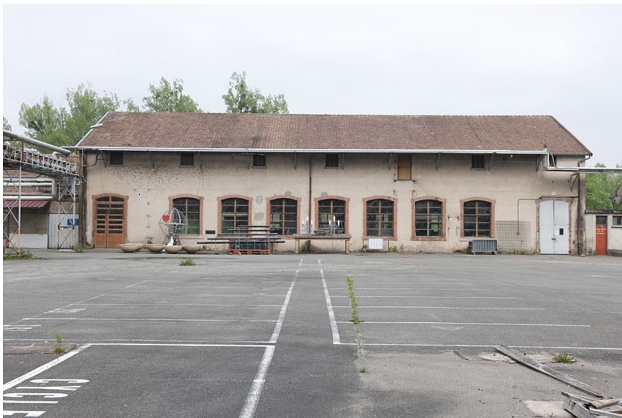
Bâtiment industriel. Vue de face.
