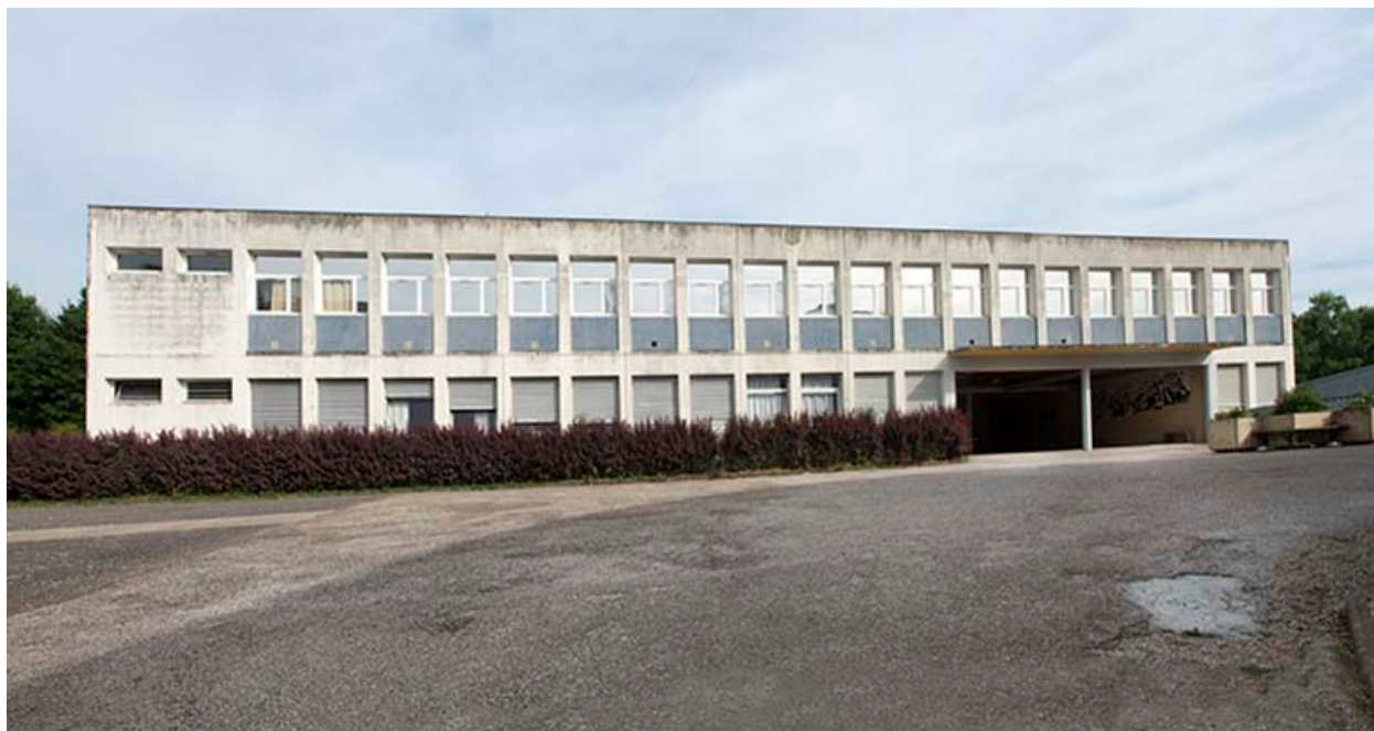
Façade sud-est de l'externat et préau.
