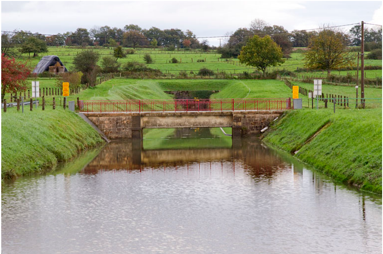
Pont routier sur le bief d'amenée.
