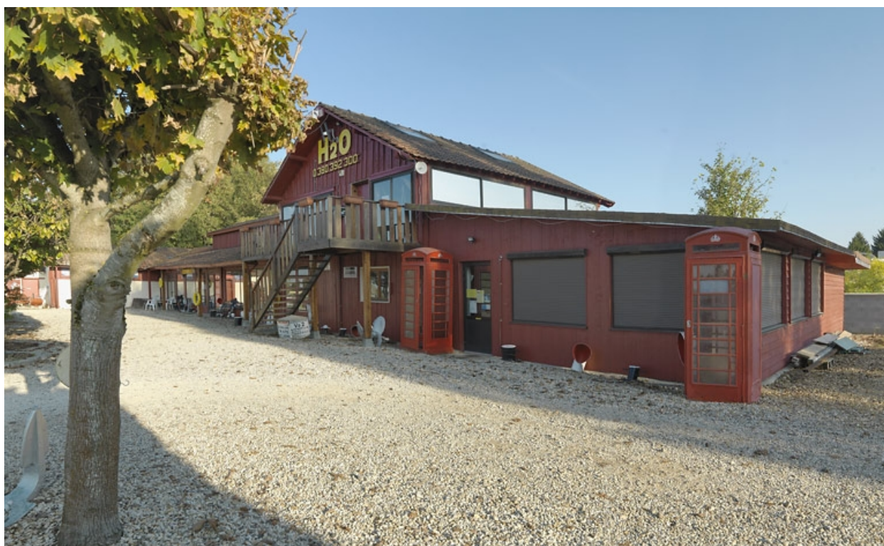
Remise transformée en capitainerie H2O.
