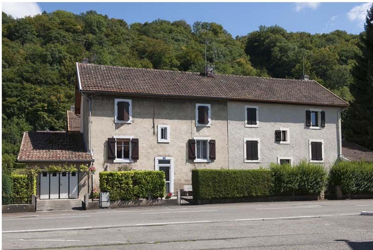
Façade ouest d'une habitation ouvrière.
