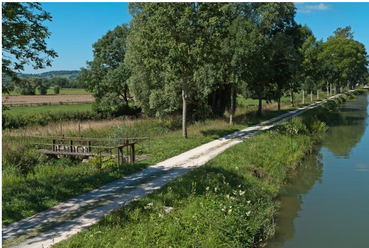
Vue des vannes de prise d'eau.
