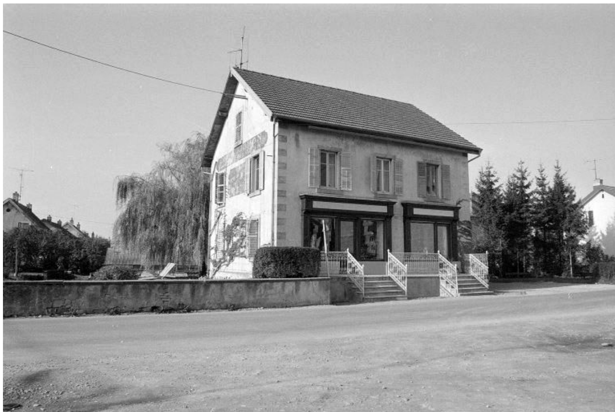
Façades antérieure et latérale gauche.
