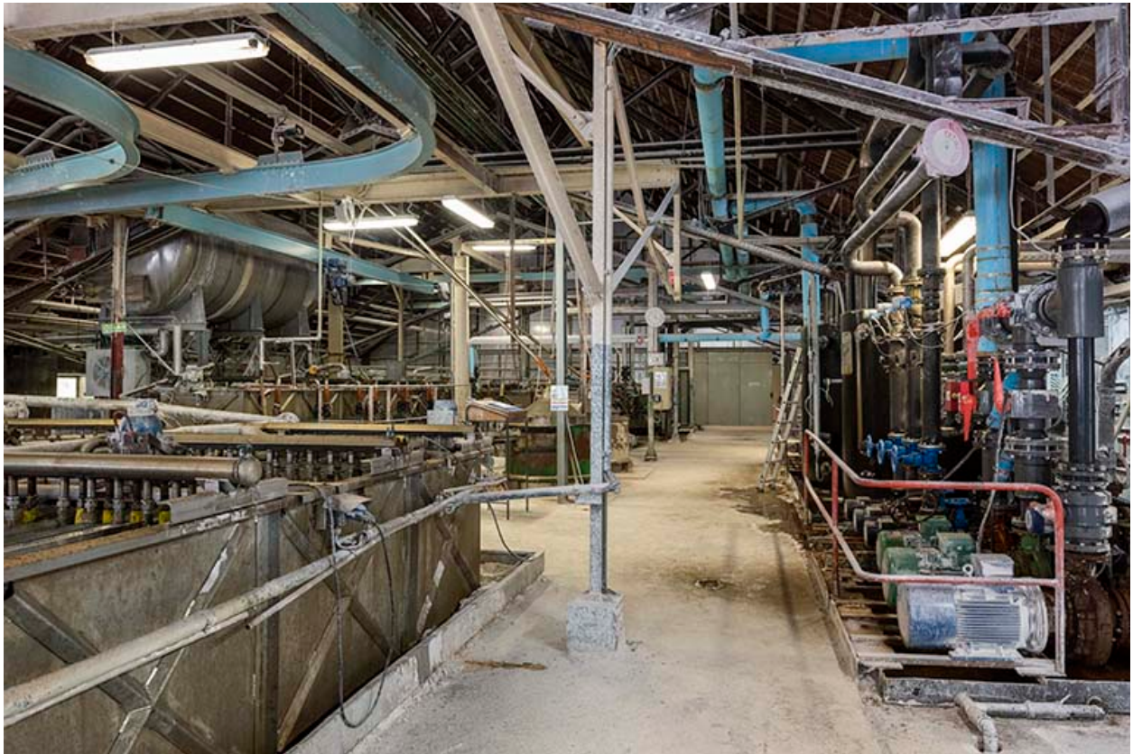
Fabrication : retraitement du sel (cristallisation).
