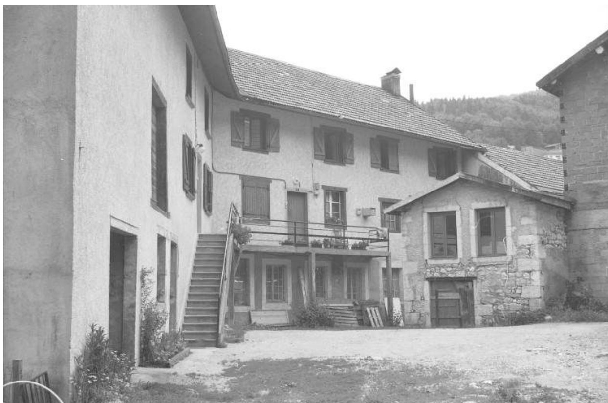
Ancienne clouterie : façades sur la cour.
