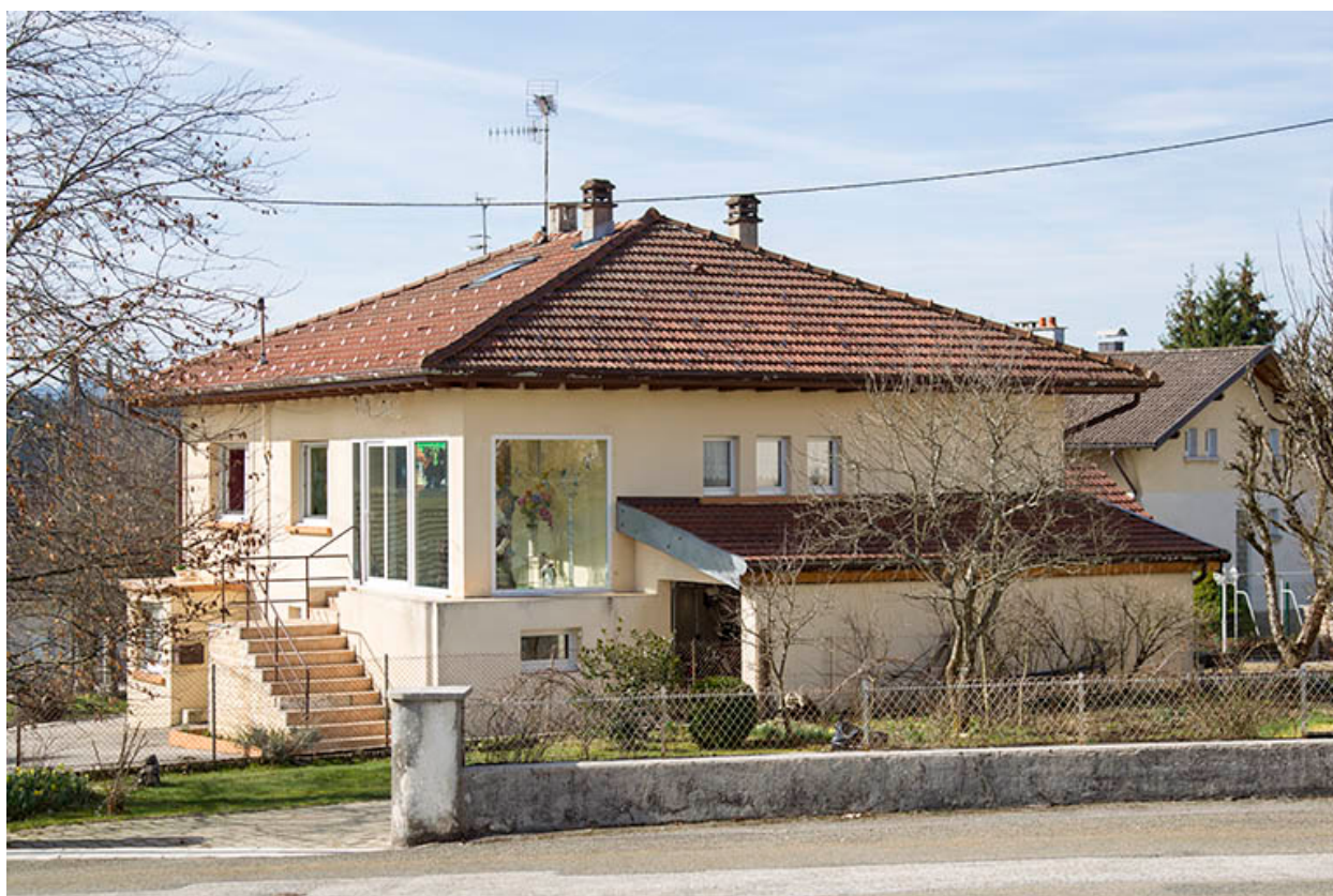
Façades antérieure et latérale droite.
