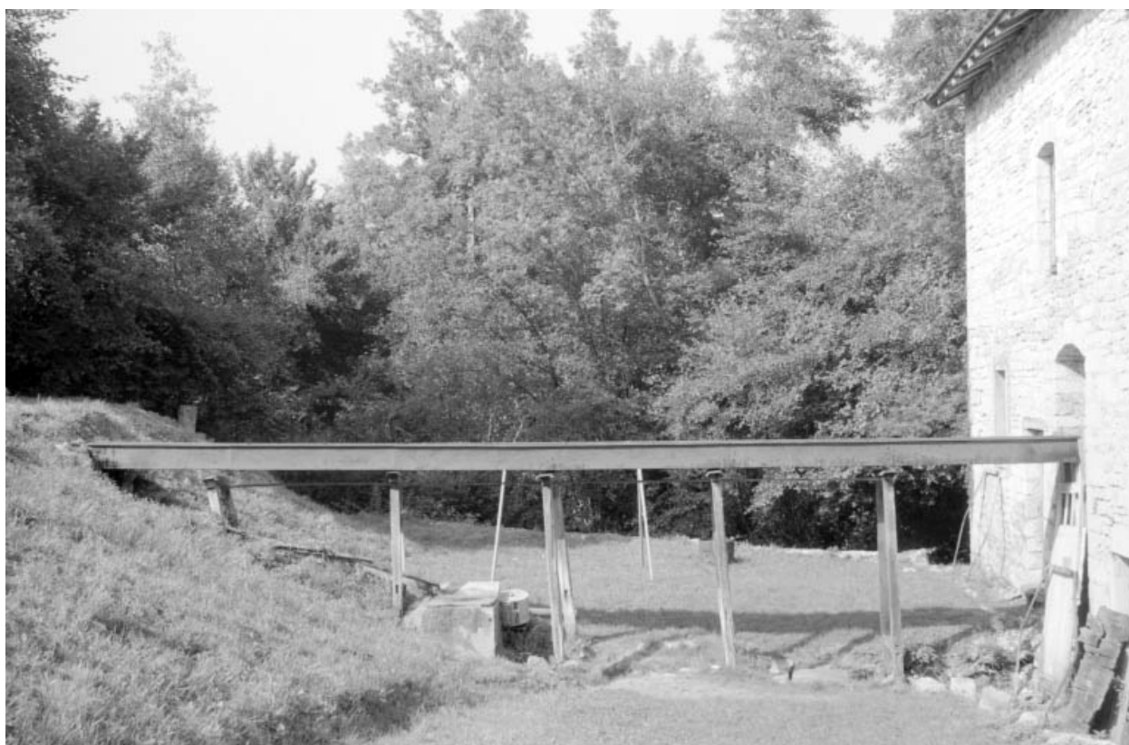
Conduite d'amenée de la roue.
