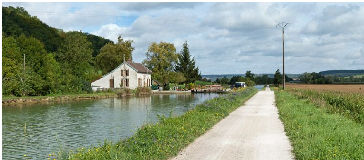
Vue du site d'écluse depuis l'amont.
