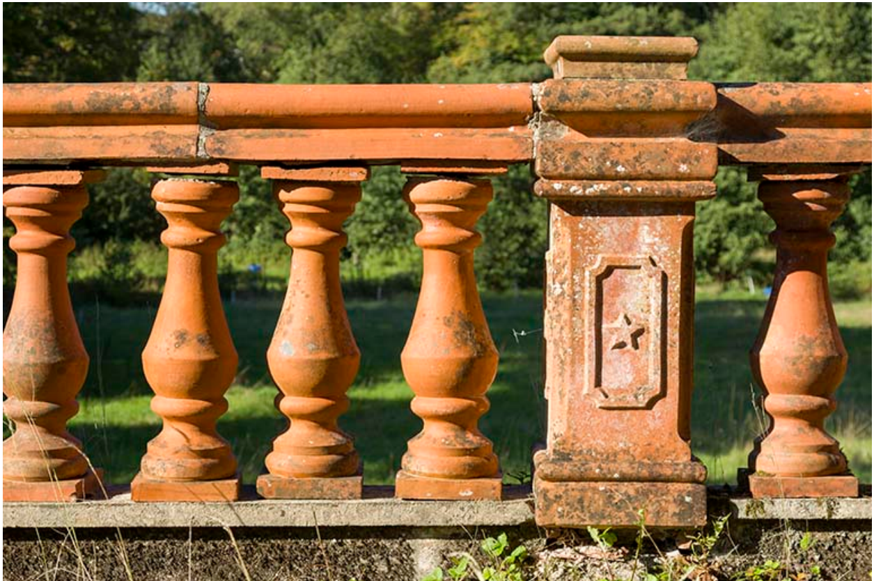
Balustrade de la terrasse, façade nord.
