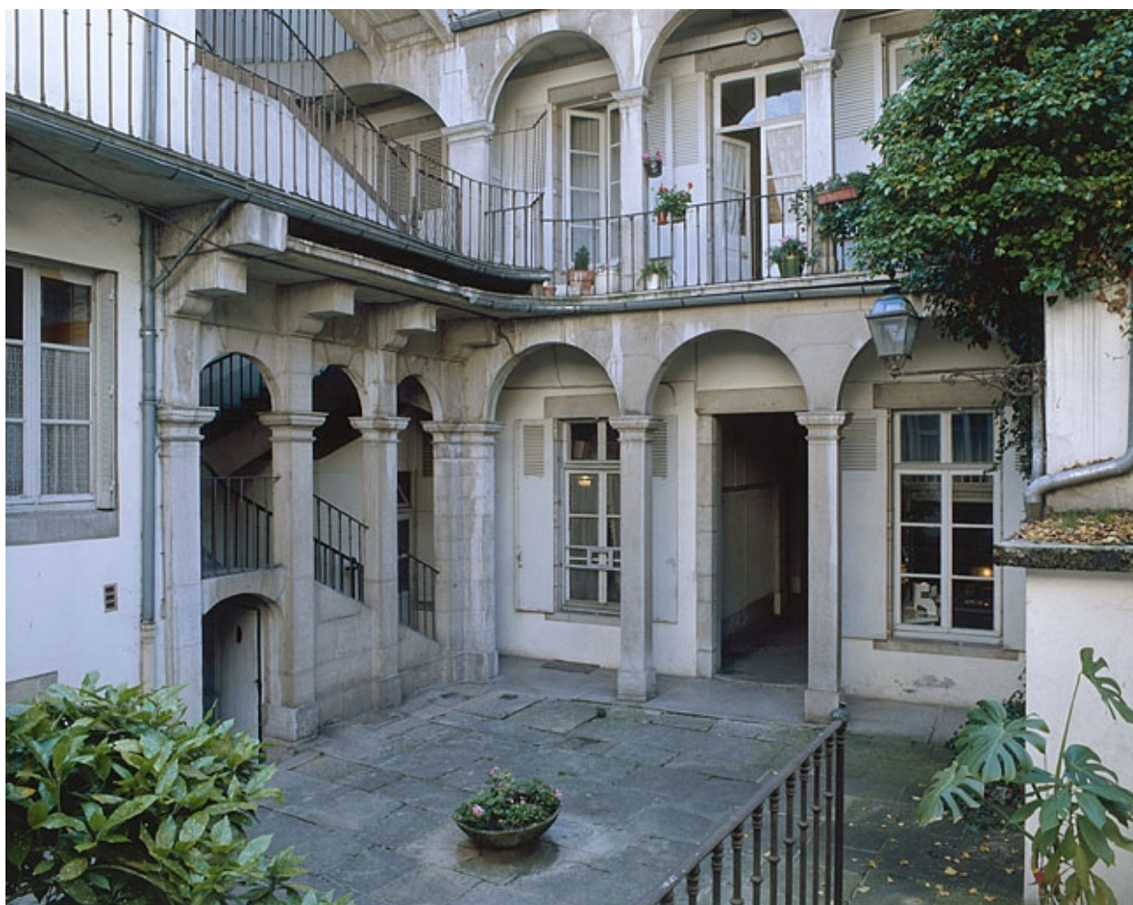
Façade sur la cour, détail.
