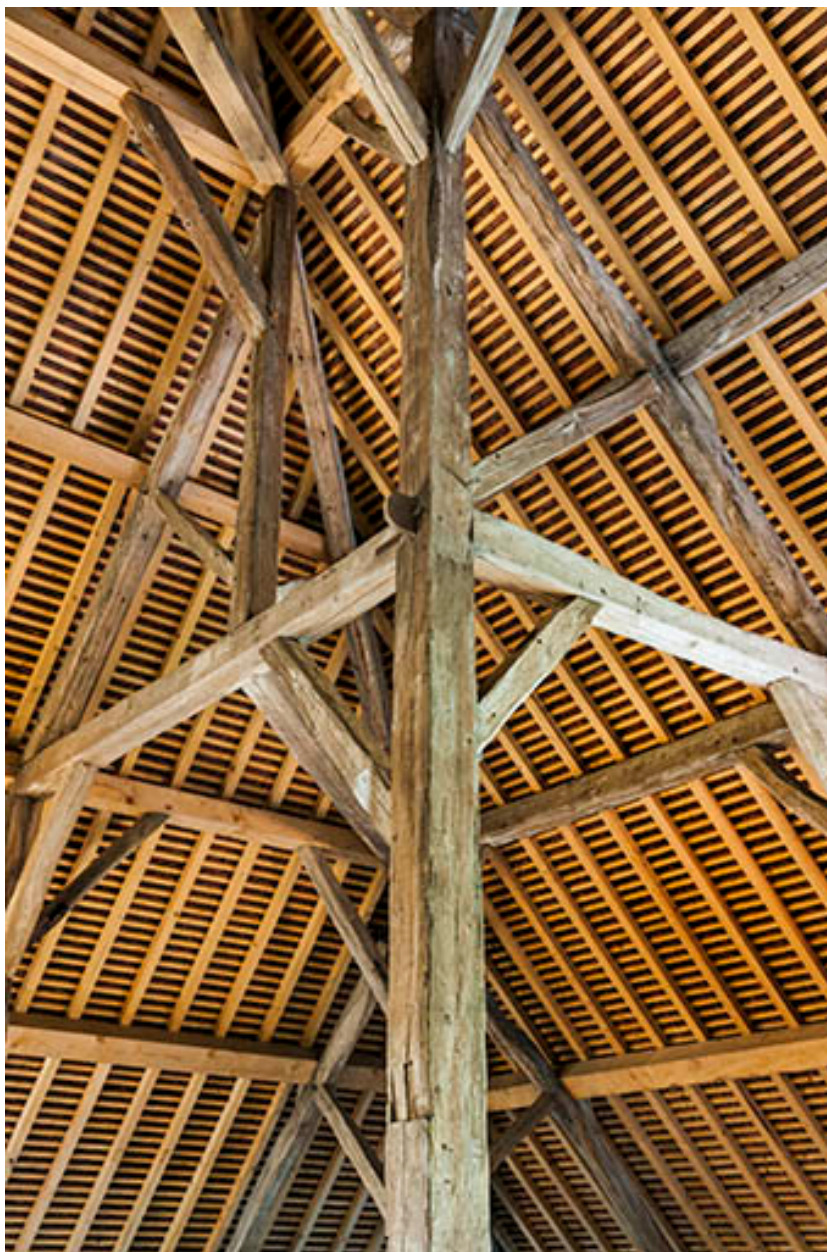
Charpente du séchoir. Détail de la croupe.
