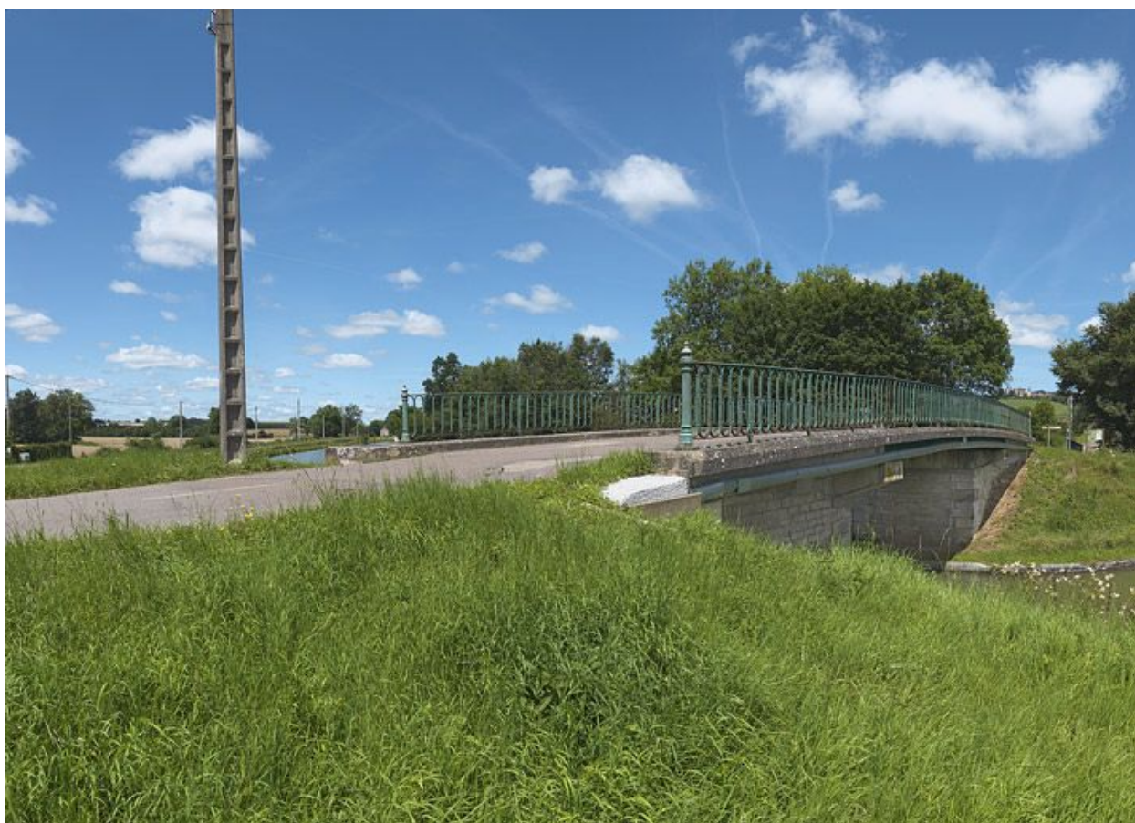
Le pont routier vu d'aval.
