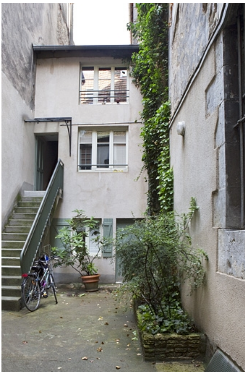
Vue d'ensemble du logis secondaire.
