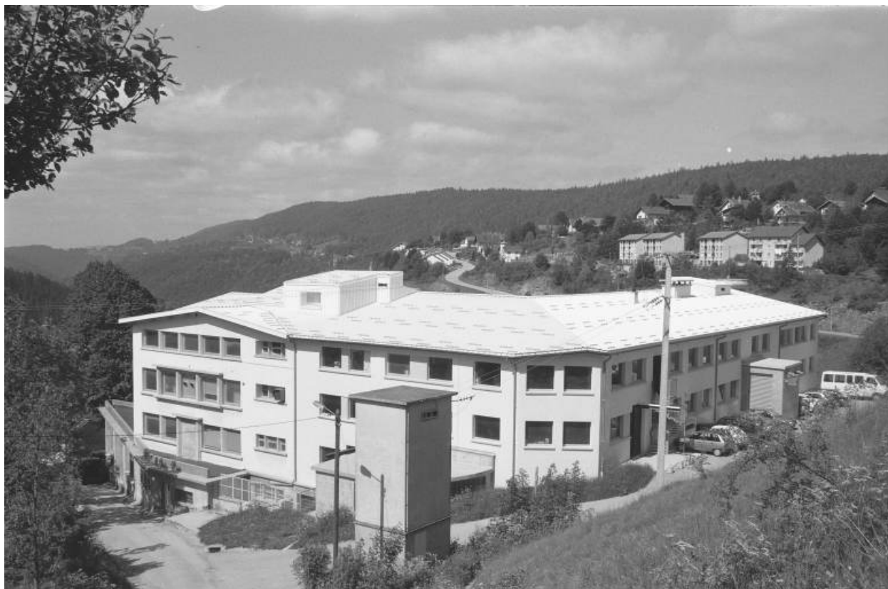
Façade postérieure des ailes nord et est.
