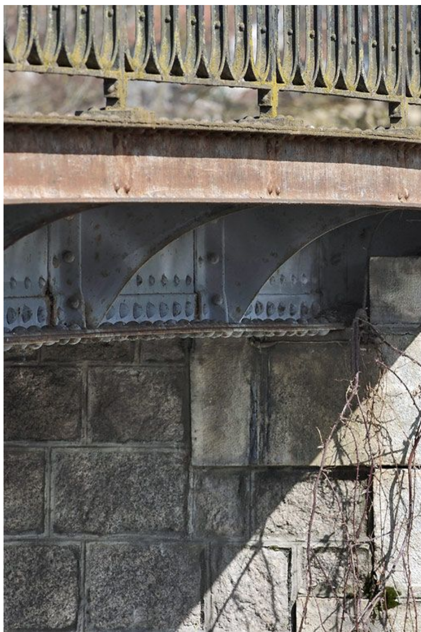
Le pont routier, détail du tablier métallique.
