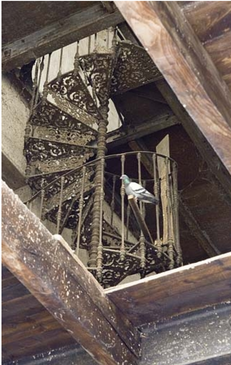
Bâtiment de rectification. Escalier intérieur en fonte.
