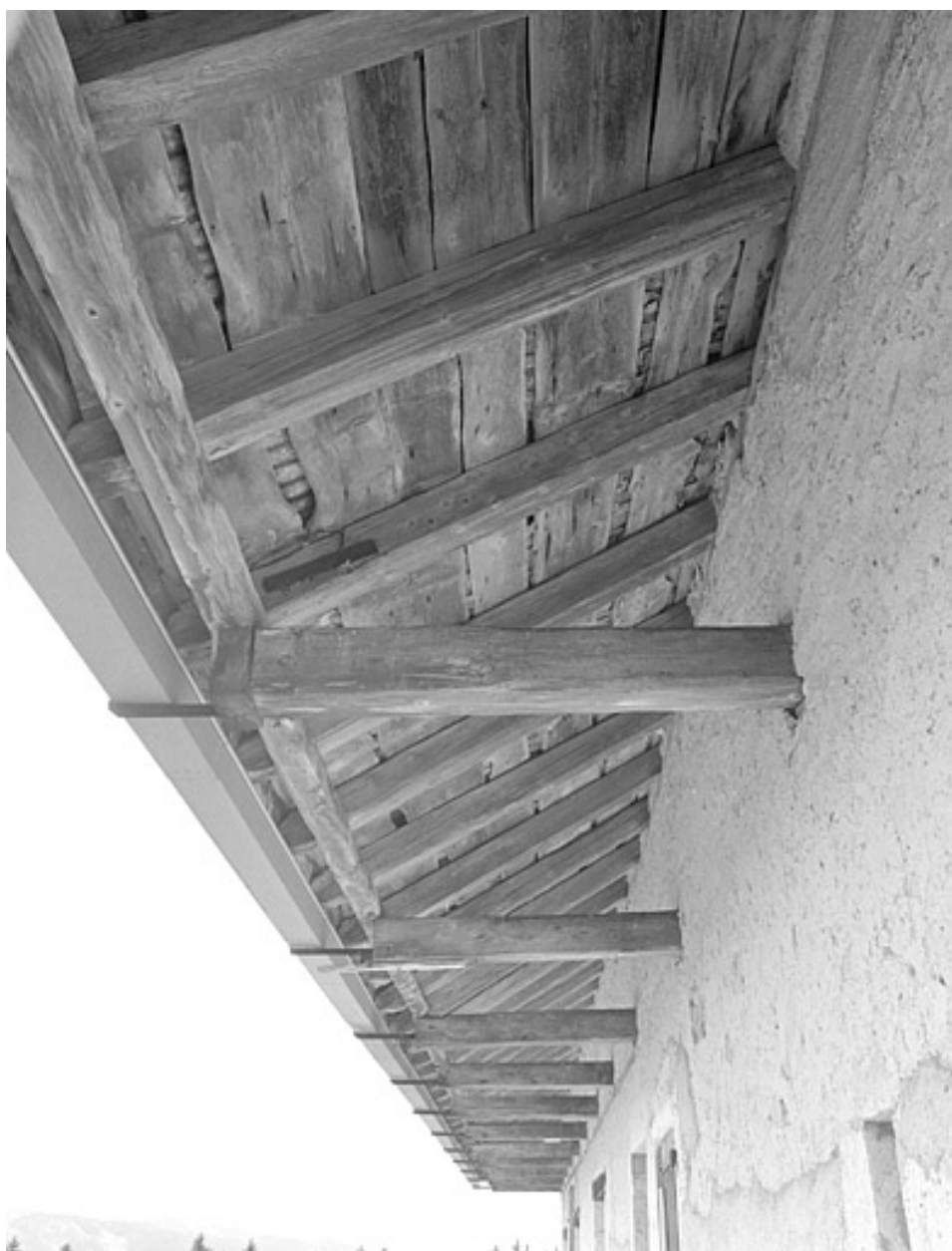
Détail de la charpente de l'avant toit.
