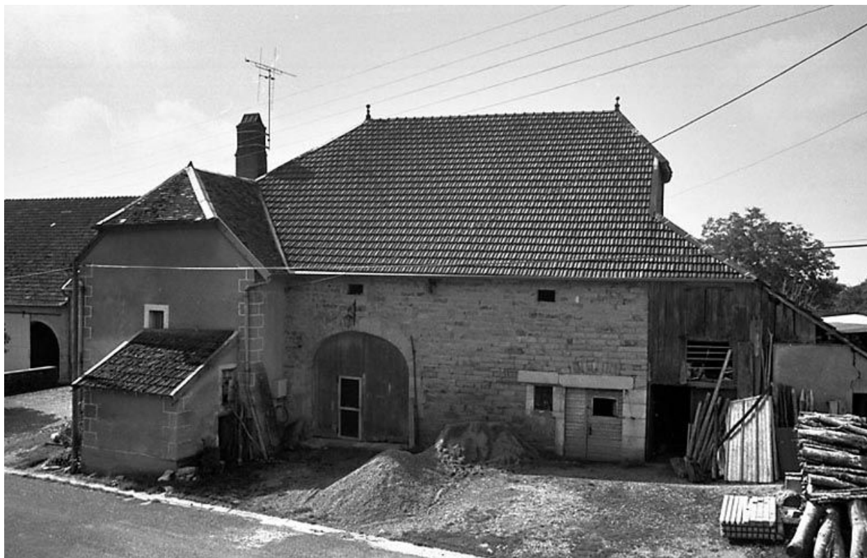
Etrelles-et-la-Montbleuse (Etrelles) : grange et écurie d'une ferme.
